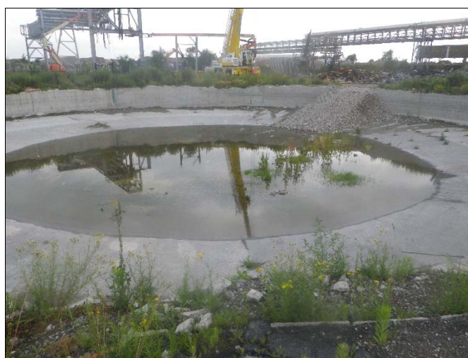
Bassin bétonné au sein des zones de démolition
